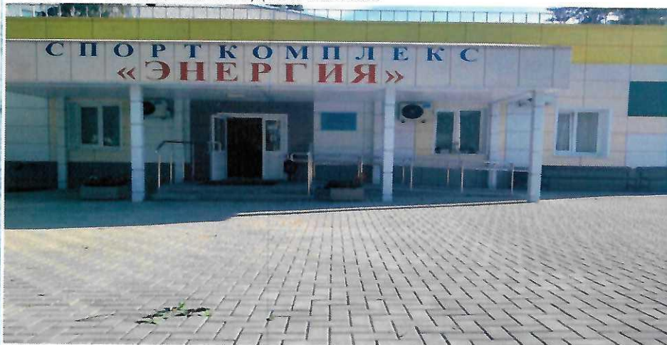
Фото 10 Главный вход на объект
