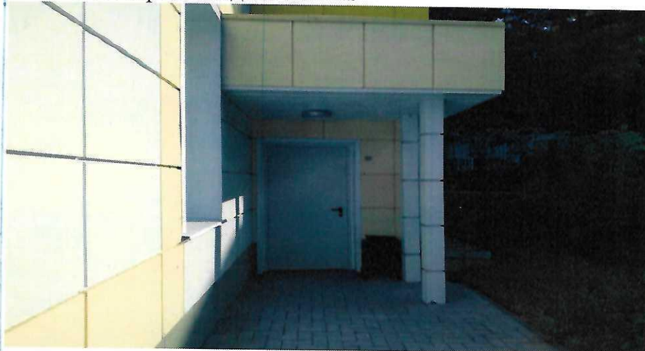
Фото 11 Второй вход на объект
