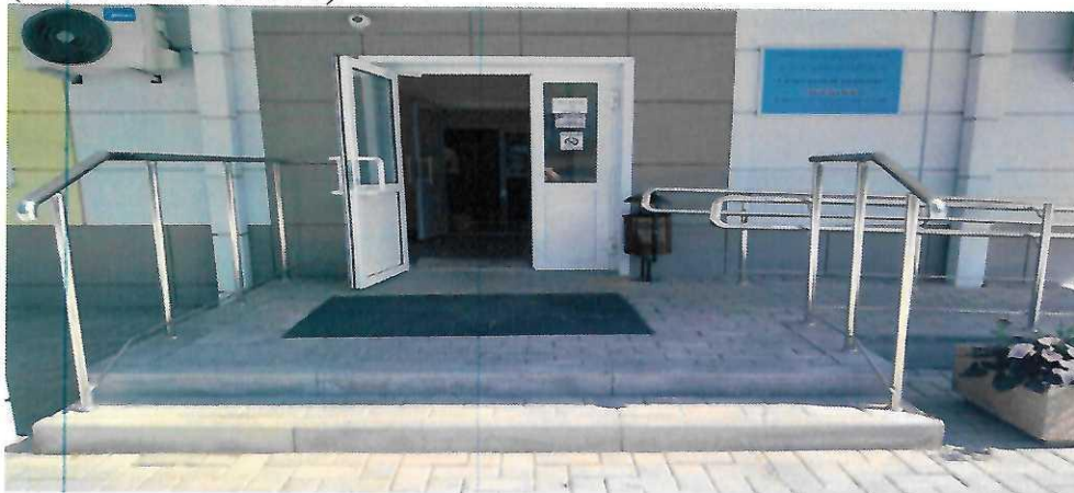
Фото 6. Входная площадка перед дверью размерами 2,5м x 2,5м (п.6.1.4 (СП59.13330.2016))
